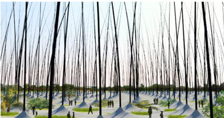
Tallos de fibra de carbono y discos de cerámica con material piezoeléctrico que con el movimiento y la presión producida por el viento producen electricidad (incluso con vientos suaves).
