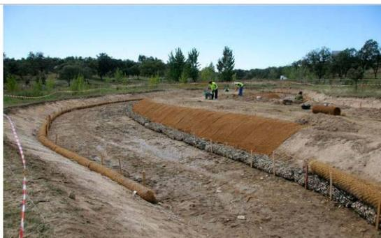
Sistema de estabilización de cauce con biorrollos de malla de coco.
